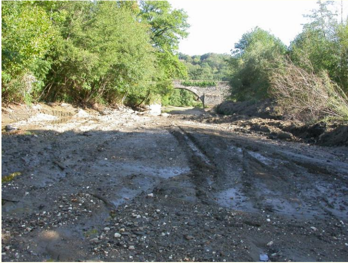
Chaussée sur le Viaur (France)
