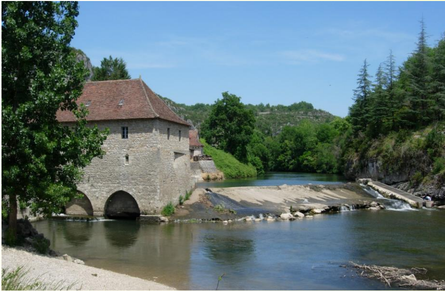
Passé à poissons sur une chaussée
